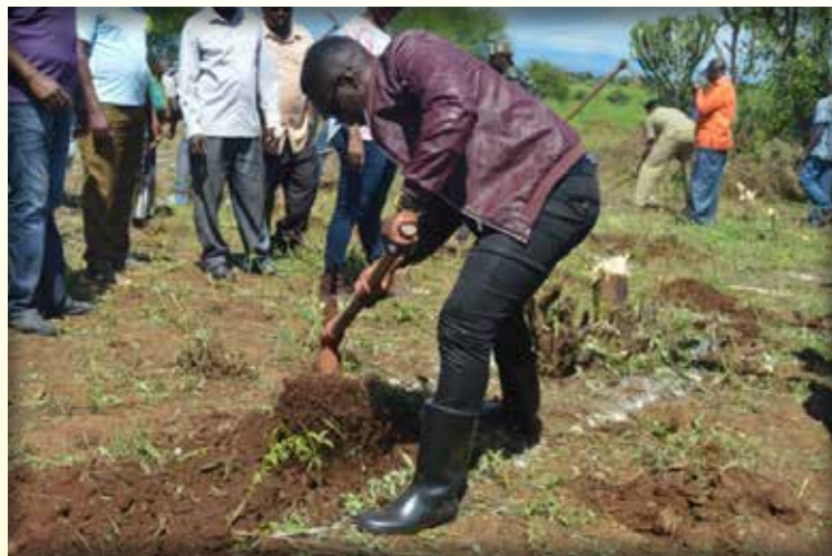
Mkuu wa Wilaya ya Hai Lengai Ole Sabaya akizindua ujenzi wa kituo cha afya kwa kuchimba msingi wa jengo.
