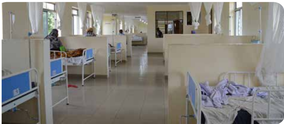
Mwonekano wa ndani kwenye jengo jipya la wodi ya wanawake kwenye hospitali ya wilaya ya Hai
