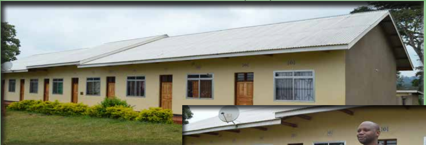
Jengo la nyumba wa walimu Six in one shule ya Sekondari Sawe
