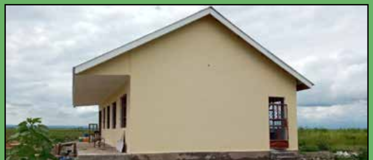
Muonekano wa Maabara kwenye Shule ya Sekondari Tambarare baada ya ujenzi kukamilika
